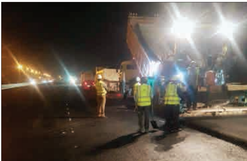
• أثناء رصف الطريق بالطبقة الثانية
