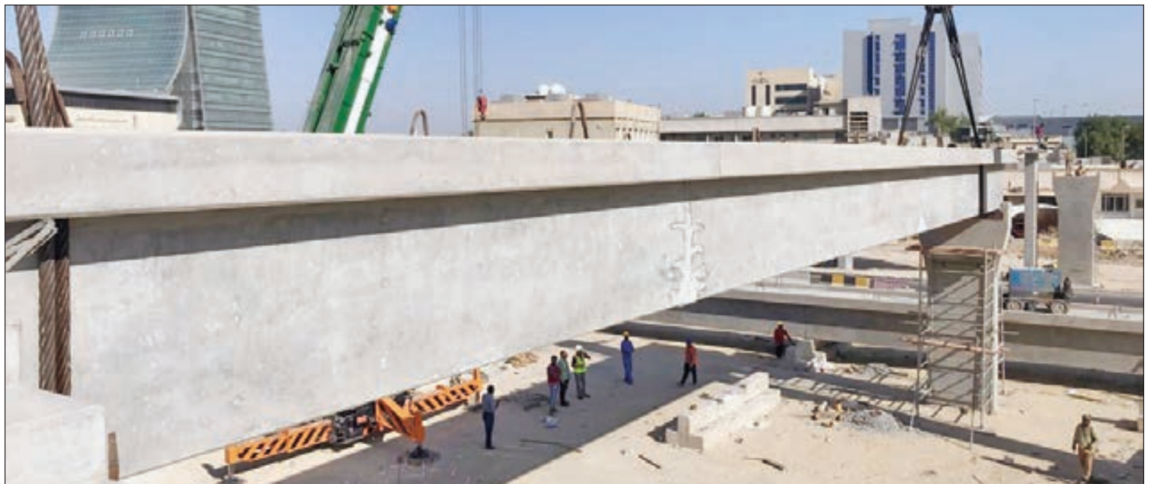
• أثناء عملية التركيب
