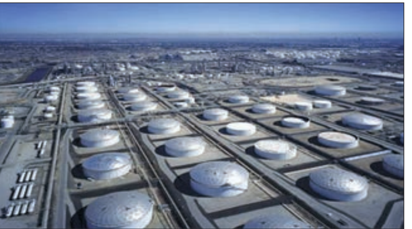
• خزانات نفط في أميركا
