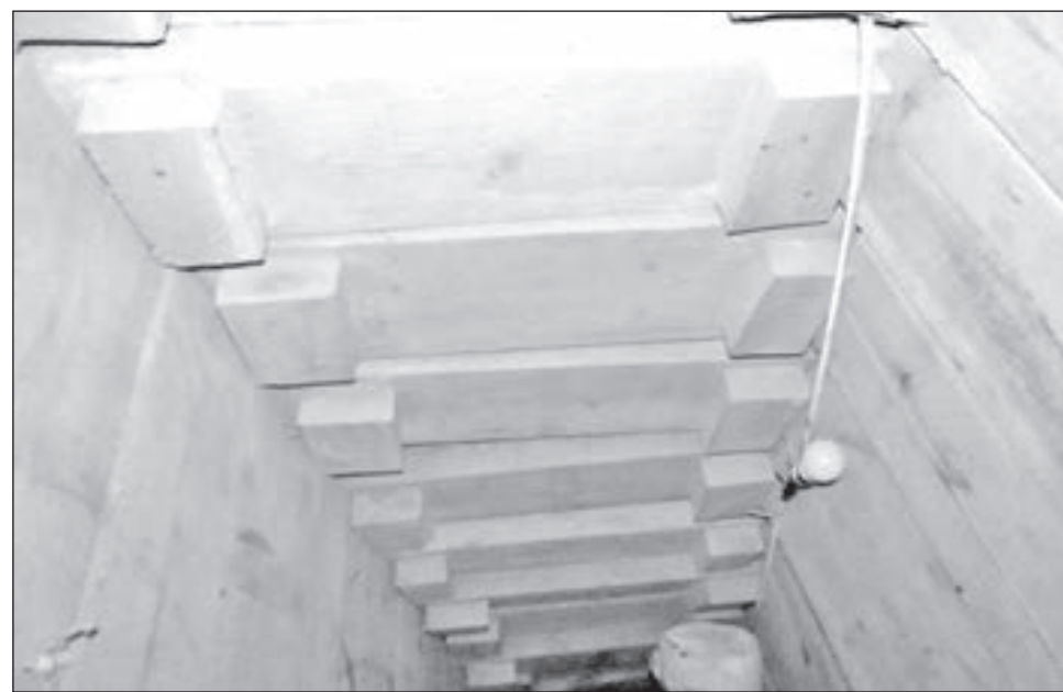
• النفق الذي تم تدميره
